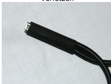
5) Schrumpfschlauch über den Stecker schieben
